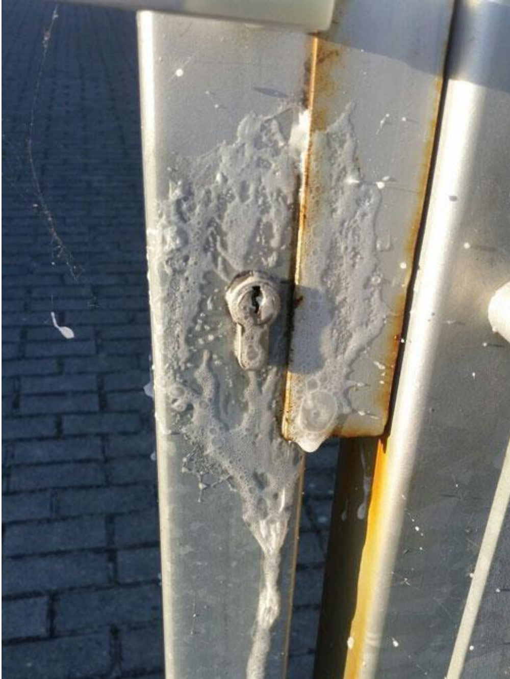
Eins der beschädigten Schlösser des Gräfenhainichener Sportforums
